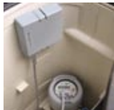
A TRA500 egy olyan Mérő illesztő egység (MIU), amelyet könnyen lehet a legtöbb impulzus üzemű mérőrendszerbe beilleszteni vagy a modernizálás során beépíteni.
